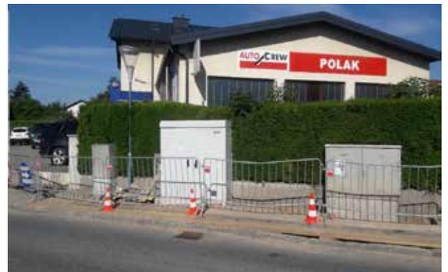
Fertigstellung der ARU-Kästen für die Lichtwellenleiter-Inbetriebnahme
